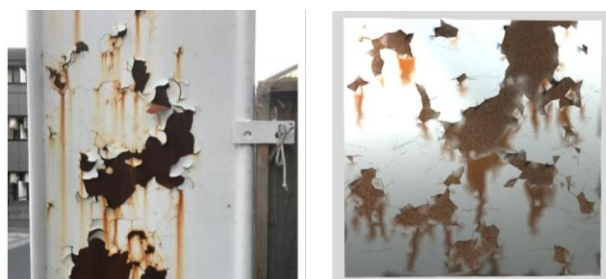
図1: 現実世界における塗膜の劣化(左)と提案手法を用いたシミュレーション結果(右)の比較
